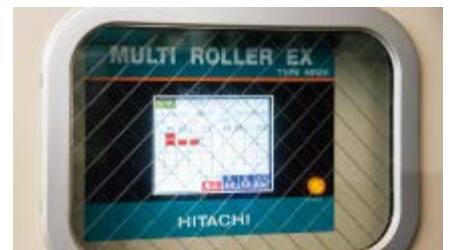
圧縮機の数制御盤「マルチローラー®EX」
