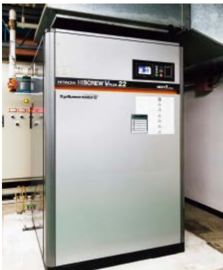
試験機の動力源として活躍している2台の日立製給油式スクロール圧縮機「HISCREW NEXTIIseries」 左が出力22kWタイプ (OSP-22VARN2)、右が出力37kWタイプ (OSP-37VARN)
