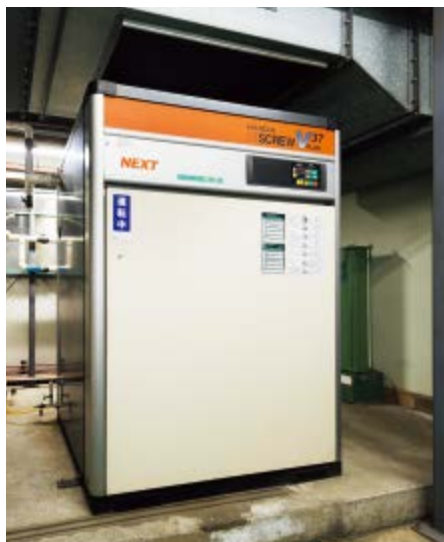
試験機の動力源として活躍している2台の日立製給油式スクロール圧縮機「HISCREW NEXTIIseries」 左が出力22kWタイプ (OSP-22VARN2)、右が出力37kWタイプ (OSP-37VARN)
