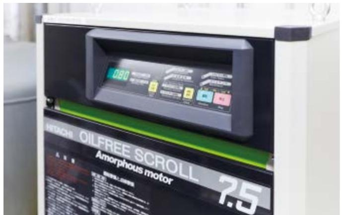
4台のコンプレッサーが置かれているコンプレッサー室。既設の5.5kW(レシプロ式)のものと比べると、「アモルファススクロール」がいかに小さいかがよくわかる。当日は既設機3台が稼働していたため、かなり大きな音が響いていたが、その分、新機種の低振動、低騒音が際立った。
