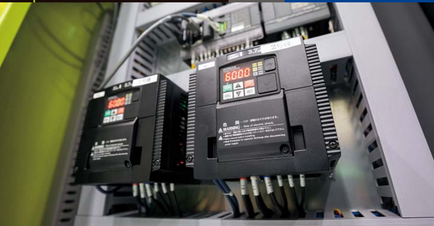
新機種のドライルーツ式真空ポンプ「FTP型シリーズ」の制御盤に設置された日立製インバータ
