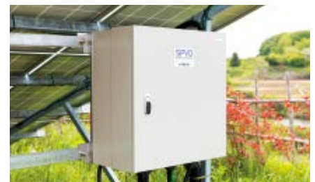
太陽光発電用パワーコンディショナ (9.9kW)
