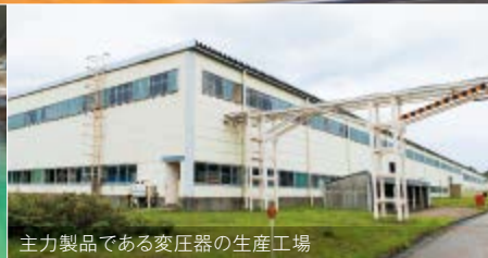
主力製品である変圧器の生産工場
