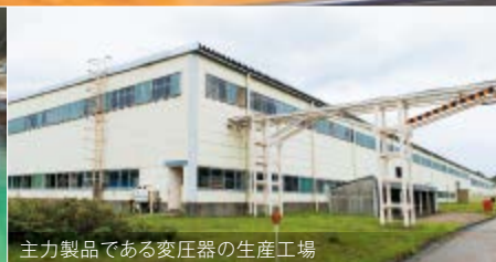
主力製品である変圧器の生産工場
