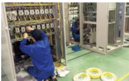
装備機器類を組み立て、配線作業へ
