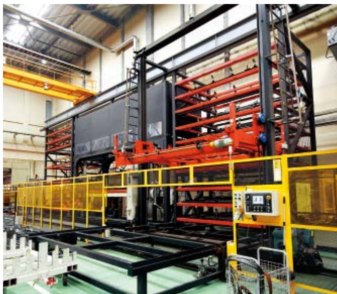
材料供給棚や加工した製品を取り出すロボットなどを含む溶接作業自動化ライン
