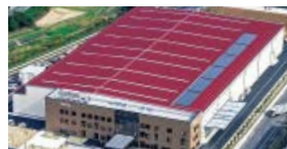
設置角度にこだわった太陽電池パネル
