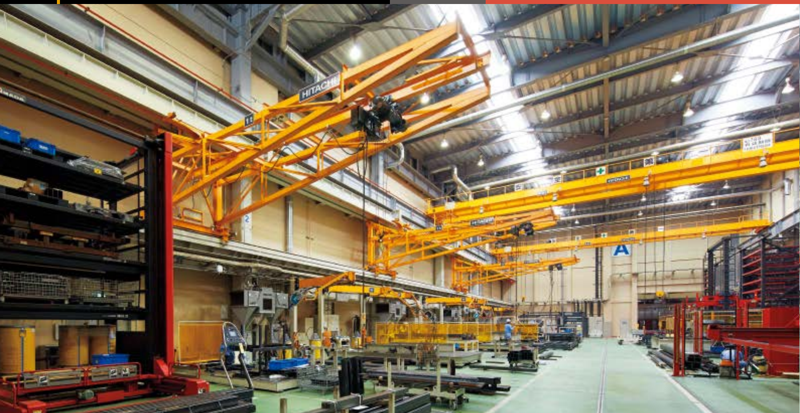
壁から突き出ているウォールクレーンを含み、工場内で17基の日立製クレーンが活躍している
