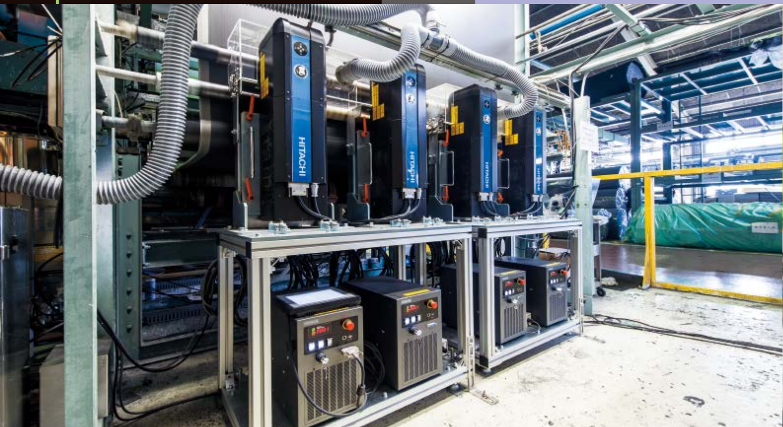
2014年春に導入された日立産機システム製のレーザーマーカ
