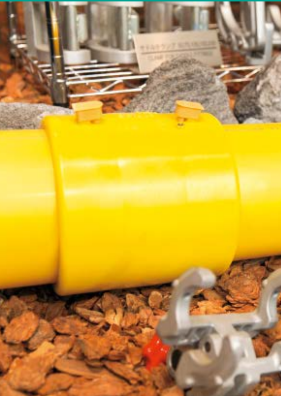
ポリエチレンのガス管を熱で融着する
