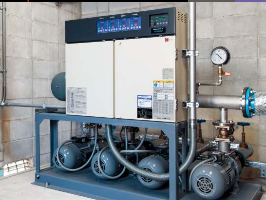
3.7kW×4台のポンプで構成された日立インバータ・ウォーターエース
