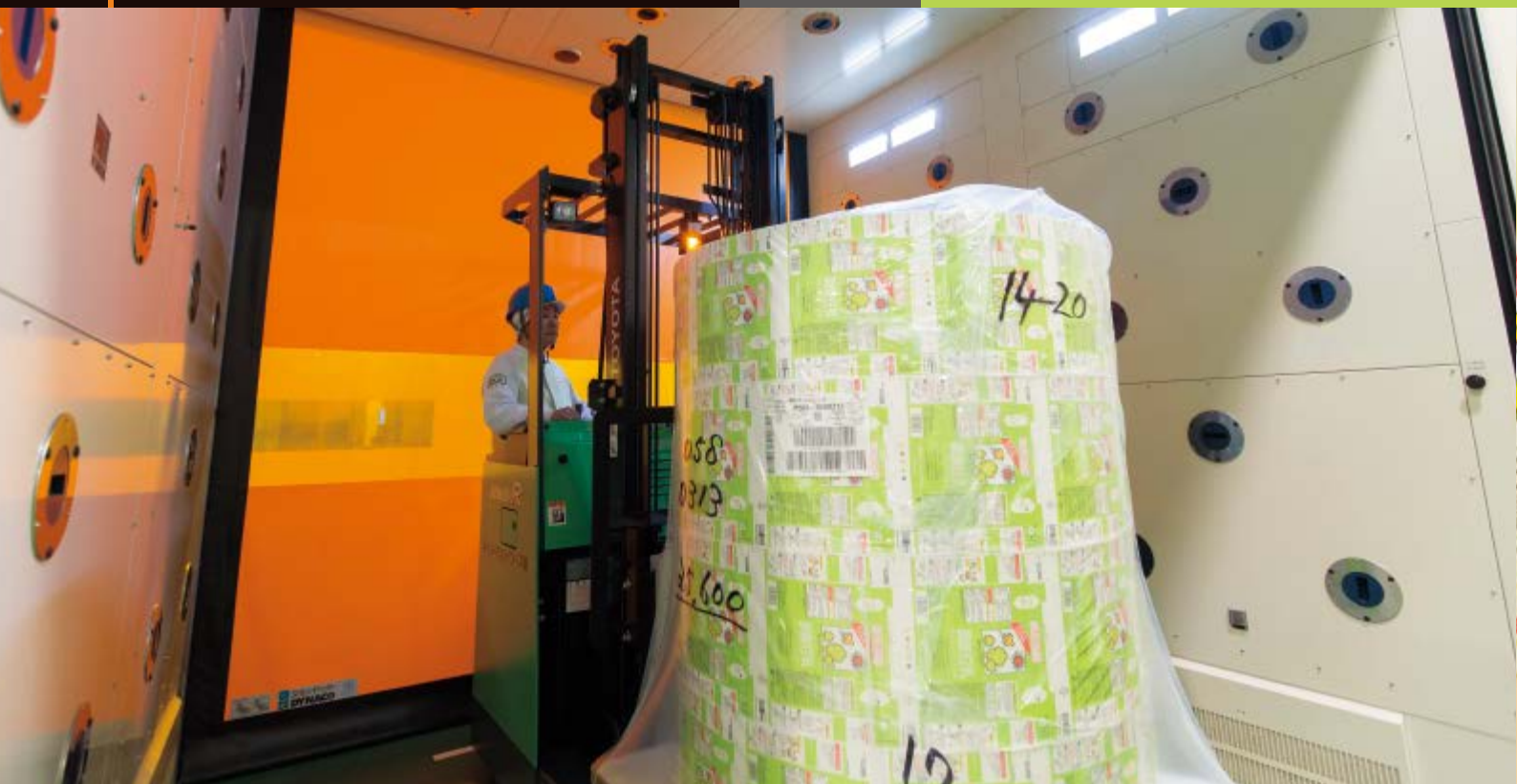
パッケージロール納入口に設置されたエアシャワー。上部のセンサーによりどこにフォークリフトが入ってもジェットが反応する
