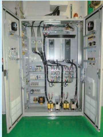
台数制御盤内写真
