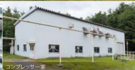
コンプレッサー室
