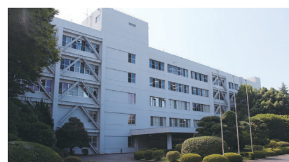
土浦事業所外観 (写真は本館)
